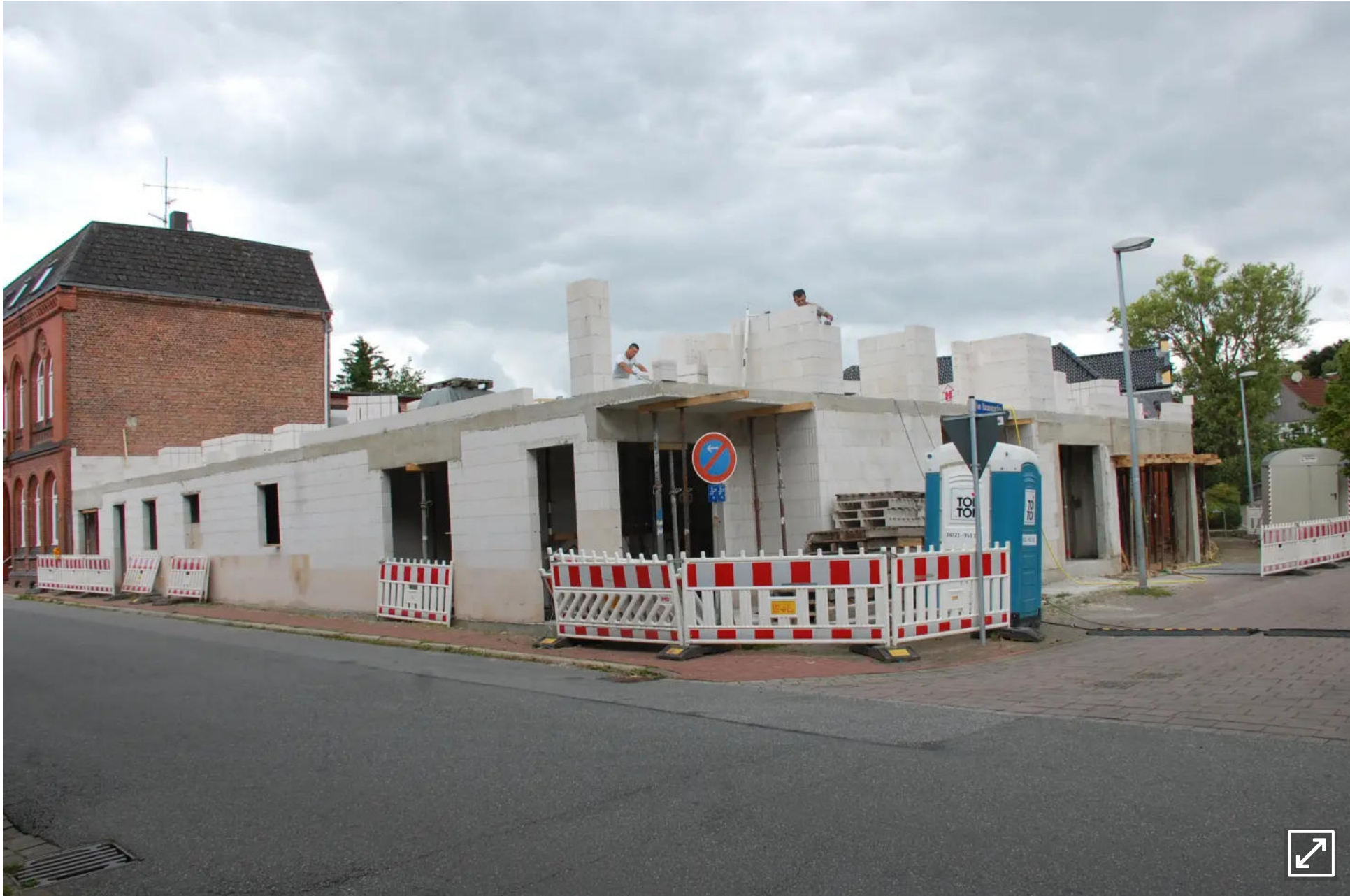
Die Bauarbeiten sind in vollem Gange. FOTO: ILKE ROSENBURG
